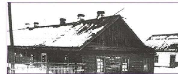
Здание врачебной амбулатории – начало здравоохранения в п. Чунский (на месте ныне действующей гостиницы «Байкал»).
